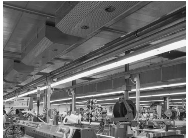
Bild 9: Trapezförmige Verdrängungsauslässe am Zuluftkanal einer Weberei
