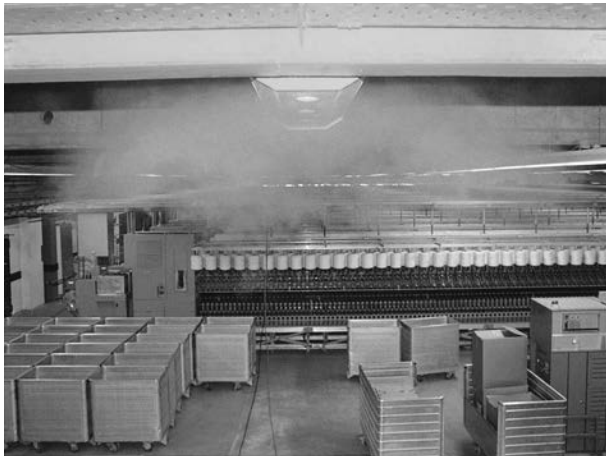
Bild 6: Trapezförmiger Verdrängungsauslass, Strahlausbreitung durch Rauchprobe sichtbar
