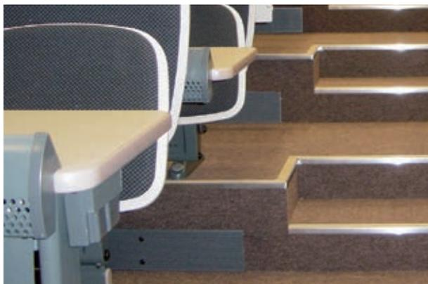
**Bild 10:** Linearer Stufenquellauslass, Kansai Universität, Osaka
