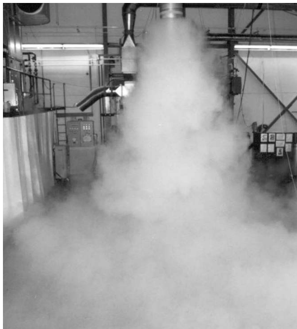
Bild 5: Ausbreitung der Luftstrahlen, durch Rauchprobe sichtbar gemacht, oben: Kühlfall; unten: Heizfall
