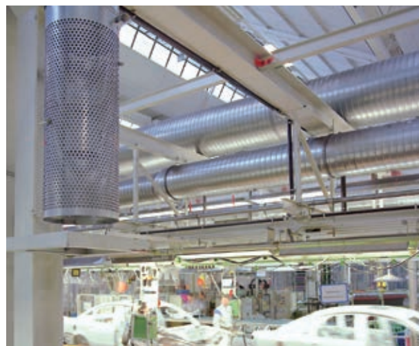
Bild 16: Runder Verdrängungsauslass in Fertigungsbereichen der Automobilindustrie
