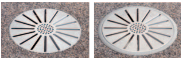
Bild 1: Bodenquellauslass in einer Bodenplatte
