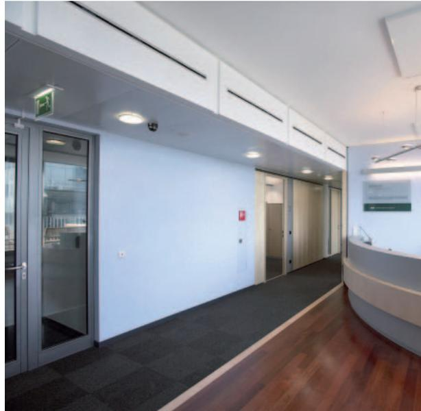
Bild 3: Wandschlitzauslass im Eingangsbereich eines Bürohauses
