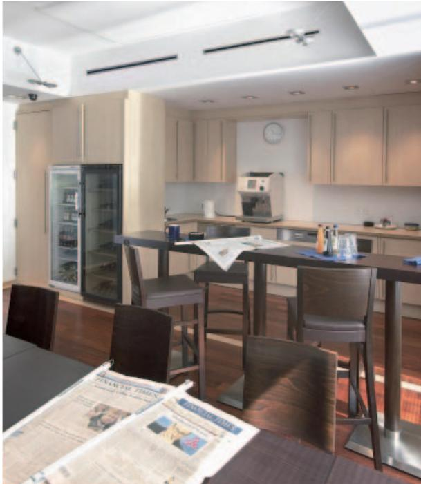
Bild 2: Wandschlitzauslass im Aufenthaltsraum eines Bürohauses
