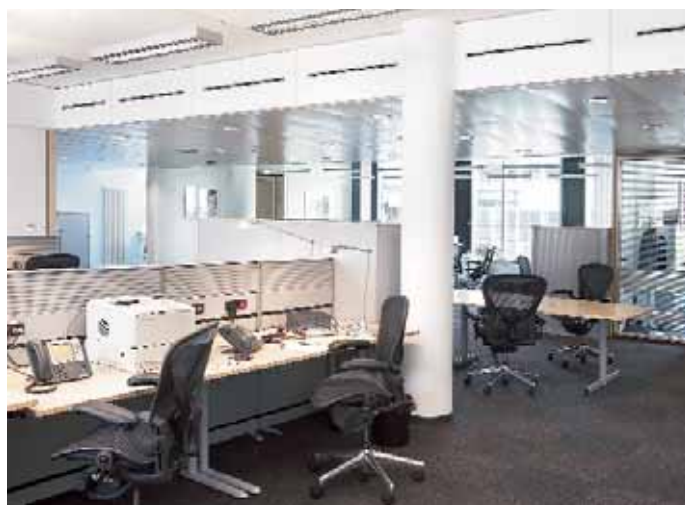
Mercer Oliver Wymann, Frankfurt/Main / D Wandlijnrooster, Type WSD (blz. 13, 2.8)
