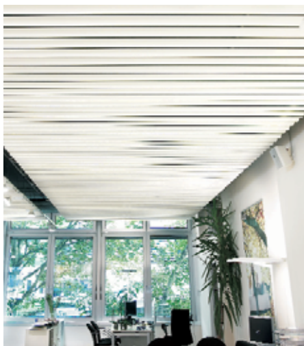
Kantoor Rahman, Eschborn / D Koelplafondsysteem, Type SKS-4/3 (blz. 25, 1.1.)
