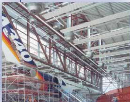
ASL Aircraft-Service, Lemwerder / D Kegelvormige verdringingsuitlaten
