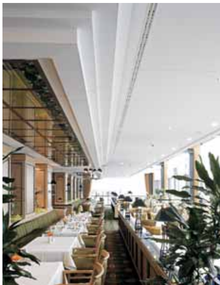
Verstelbaar Inductie lijnrooster, Type IN-V (blz. 10, 1.9)
