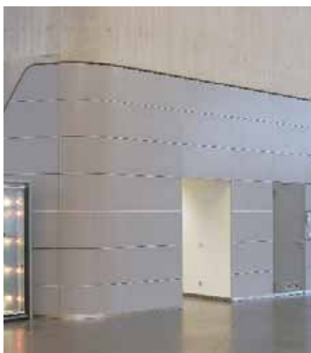
BMW AG, Leipzig / D Speciale uitvoering rechthoekig verdringingsrooster, Type Q-R (blz. 16, 4.1)
