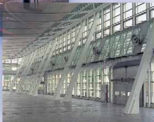
Beurs Hannover, Hal 26 / D Zwenkbare verstraaluitlaat en verdringingsuitlaat in glazen kanaal
