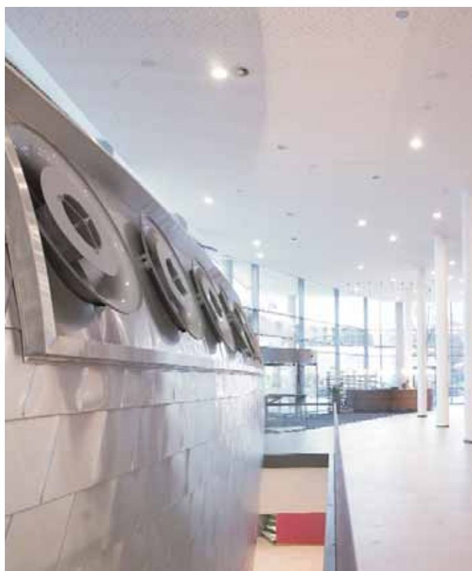
Beiersdorf AG, Hamburg / D Zwenkbare verstraal uitlaat, Type SW (blz. 12, 2.4)
