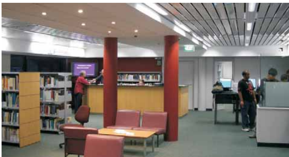
Universiteit van Wollonong, Gwynneville / NSW / AUS Koelplafondsysteem, Type SKS 5/3 (blz. 25, 1.2.)
