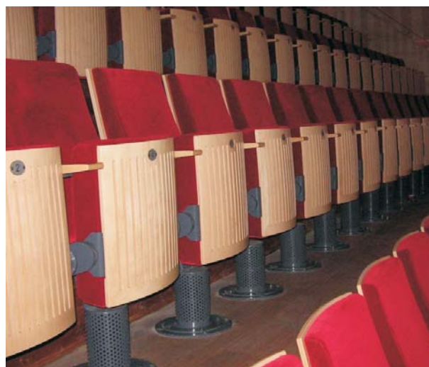
Seat displacement outlet, type Q-St, in the 'Muziekgebouw aan 't IJ', Amsterdam / NL
