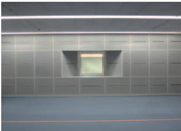
Luftauslasswand mit Lochblechkassetten und Induktivauslässen. Schützenaufsichtsfenster mit luftführenden Laibungen.
