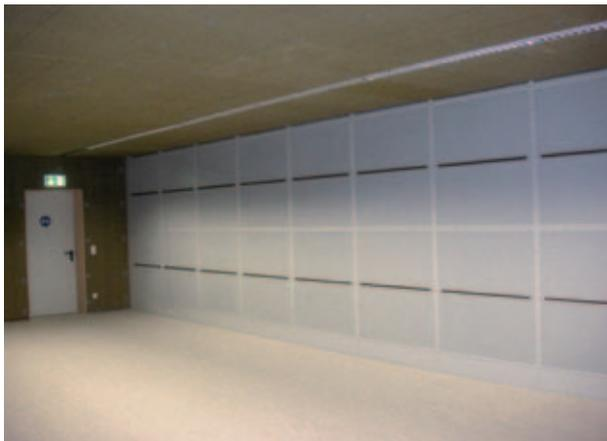
Luftauslasswand mit Lochblechkassetten und Induktivauslässen
