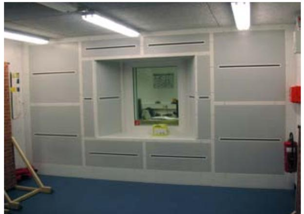
Neue Ausführung Luftauslasswand Fabrikat Krantz Komponenten mit Erreichung der optimalen Raumluftgeschwindigkeit und Strömungsrichtung
