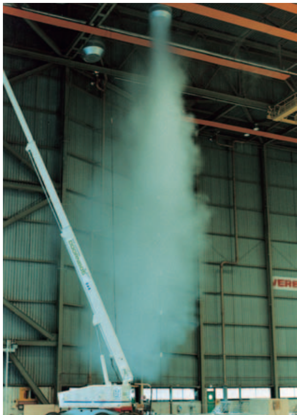
Bild 8: Eindringtiefe der Zuluftstrahlen durch Rauchprobe sichtbar gemacht
