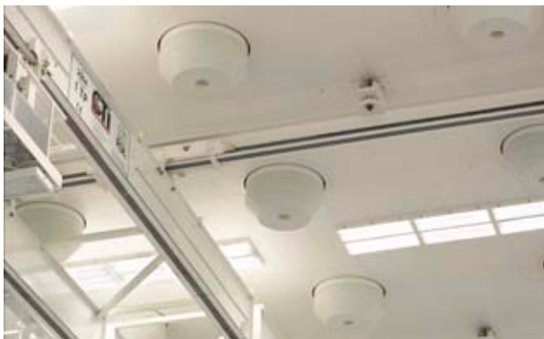
Bild 1: Kegelförmiger Verdrängungsauslass an der Decke einer 26 m hohen Halle
