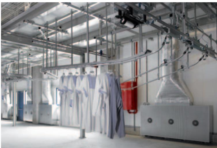
**Bild 7:** Luftdurchlass in einer Industriereinigung
