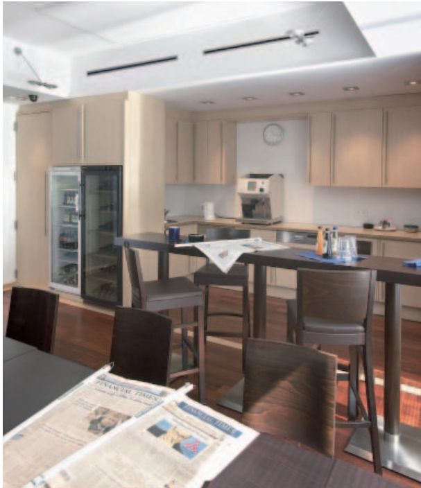
Bild 2: Wandschlitzauslass im Aufenthaltsraum eines Bürohauses
