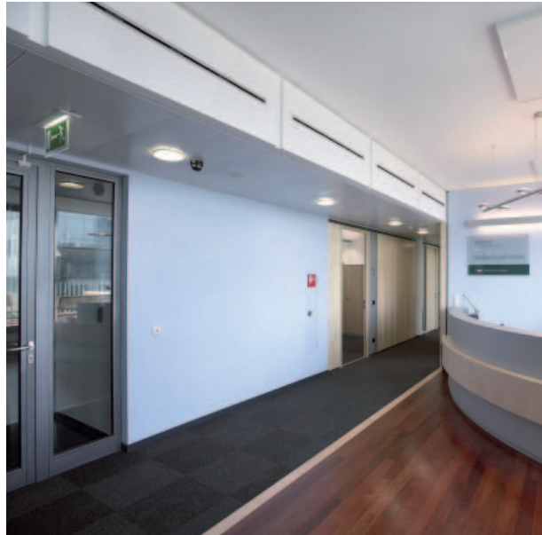
Bild 3: Wandschlitzauslass im Eingangsbereich eines Bürohauses
