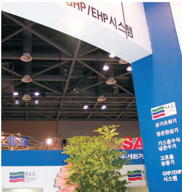
Bild 11: Verstellbarer Radialauslaß RA-V2 in einer Messehalle
