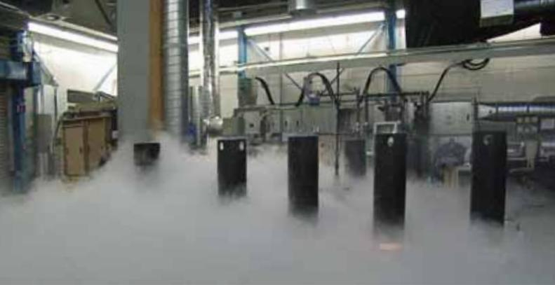
Verdrängungslüftung für eine Fertigungshalle in der Automobilindustrie
