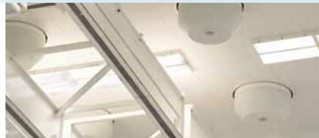
Turbulenzarme Verdrängungslüftung in Flugzeuglackierhalle
