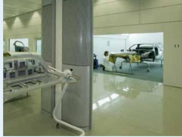
Quell-Luftdurchlass, in einer Säule integriert
