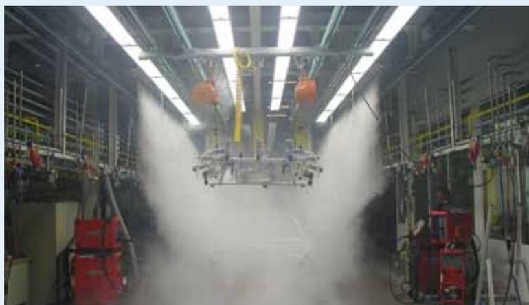
Direkte Arbeitsplatzbelüftung in der Automobilindustrie
