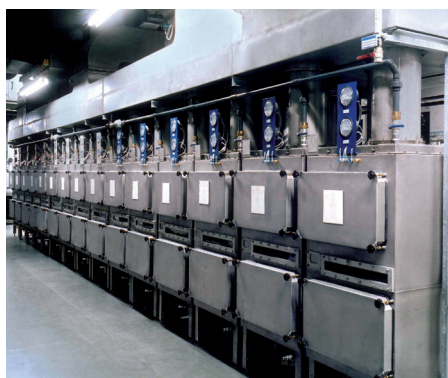
Fijnstof-filtersysteem voor de nucleaire industrie, "Systeem Karlsruhe" tijdelijke opslag Noord, kerncentrale in Lubmin (Dld)
