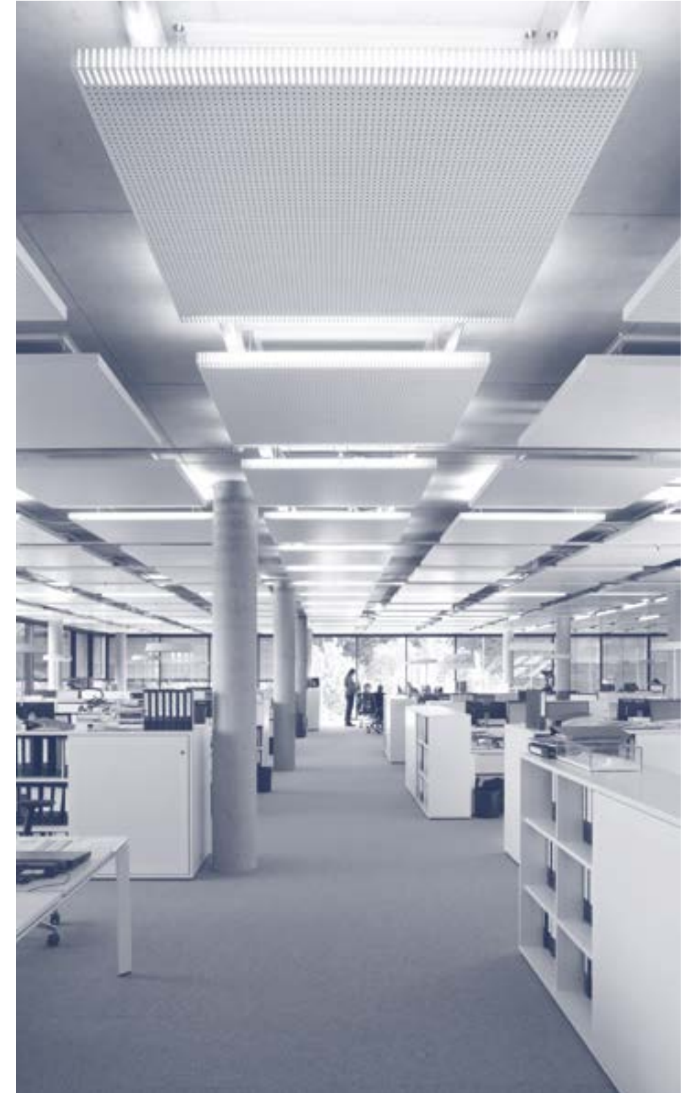
Kontakt-Kühldeckensystem ausgeführt als Kühlsegl Kühl- und Heizsysteme
