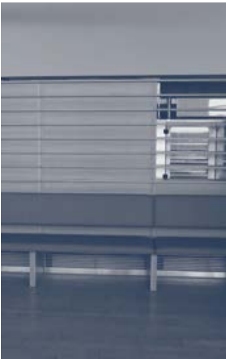
Sockelquellauslass Q-S Quell-Luftdurchlässe für den Komfortbereich
