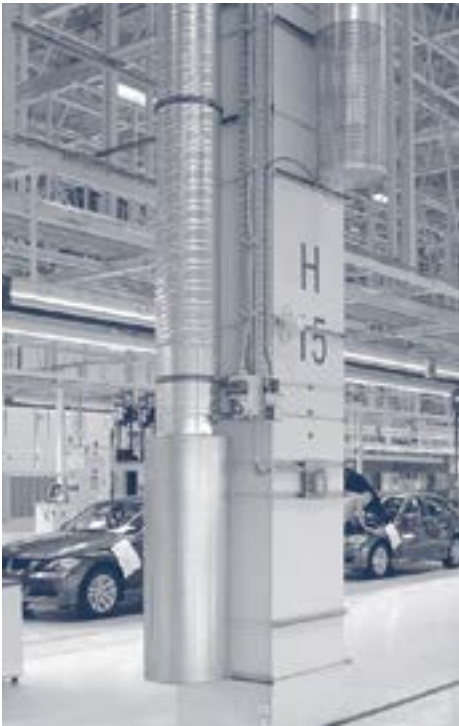
Runder Verdrängungsauslass für Boden- aufstellung VA-Z Verdrängungs-Luftdurch- lässe für den Industriebereich
