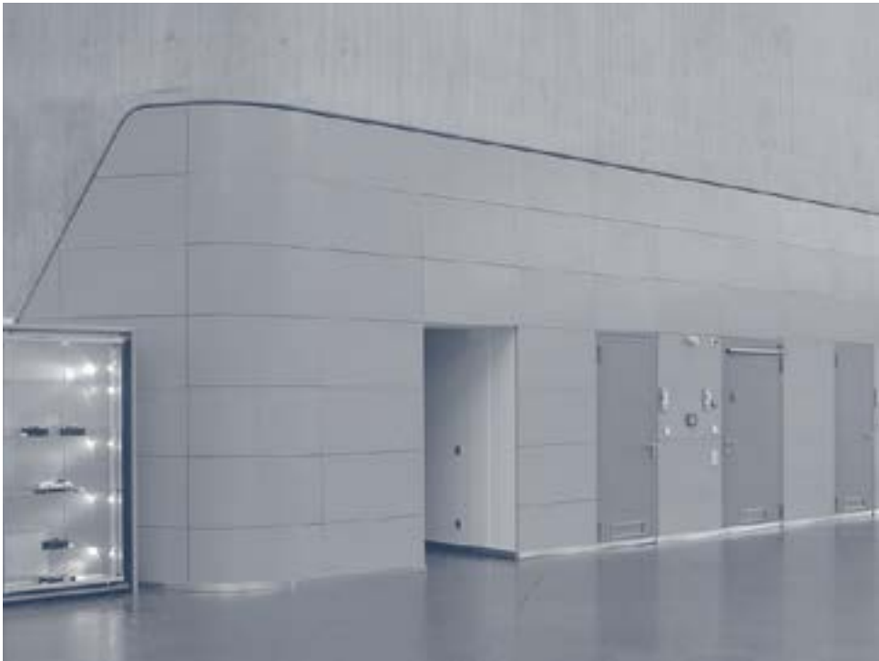
Rechteckiger Quellauslass Q-R Quell-Luftwand aus speziell modifizierten Quell-Luftkassetten Quell-Luftdurchlässe für den Komfortbereich
