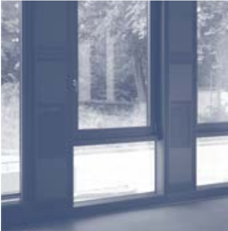
Fraunhofer inHaus-Zentrum, Duisburg
