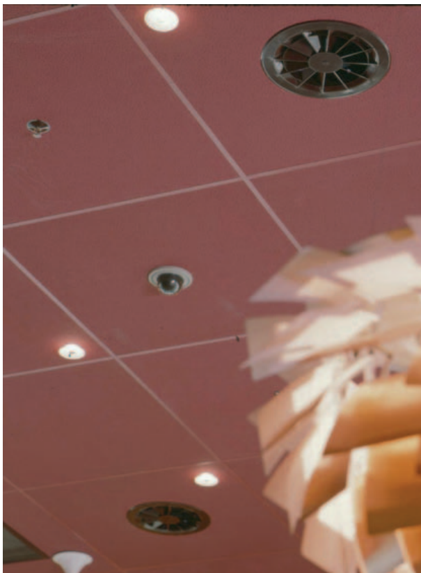
Bild 7: Verstellbarer Radialauslass in der Decke eines Restaurants, Ausschnitt
