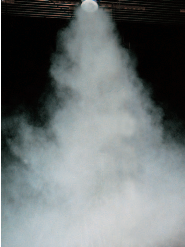
Bild 6: Vertikales Ausblasen im Heizfall aus großer Höhe
