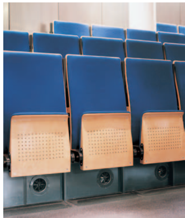
Bild 5: Stufendrallauslässe, Drallauslass DS-DD-DN 100, in einem Auditorium
