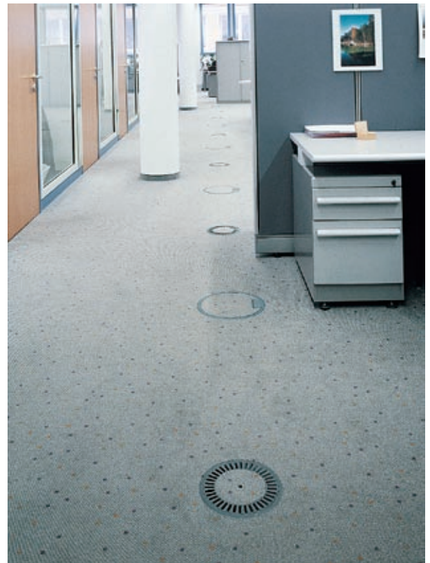
Bild 5: NTK-Bodendrallauslass in einem Bürogebäude
