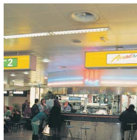
Drallauslaß, Typ DD-N in der Abfertigungshalle Flughafen Wien / A
