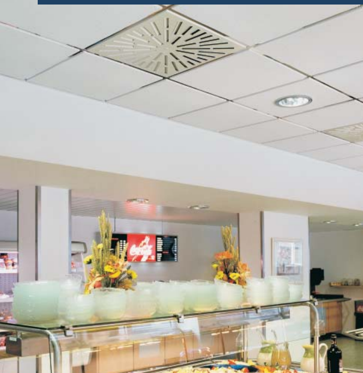
Radialer Lamellenauslaß, Typ RL-Q in der Kantine "Maul Belser Medienverbund", Nürnberg
