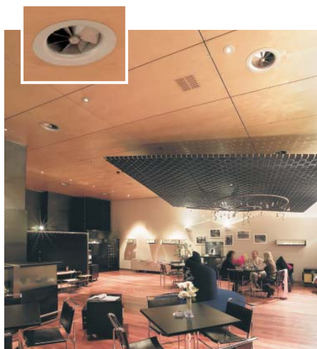
Drallauslaß, Typ DD-N in der Kantine Swarovski Kristallwelten, Wattens / A
