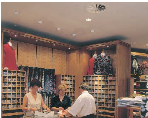
Radialauslaß, Typ RA-N in einem Verkaufsraum der Gerich KG, Wiesbaden
