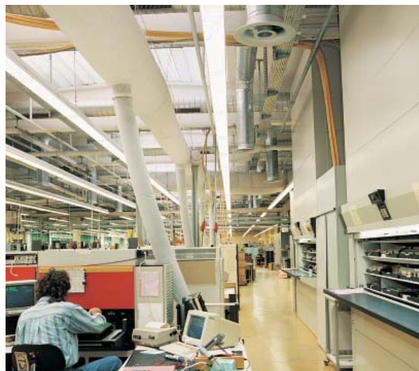
Variabler Drallauslaß mit Kernrohr, Typ DD-VK im Fertigungsbereich von Alcatel / SEL, Werk Gunzenhausen
