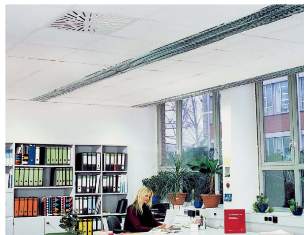
Radialer Lamellenauslaß in einem Büroraum, Typ RL-Q
