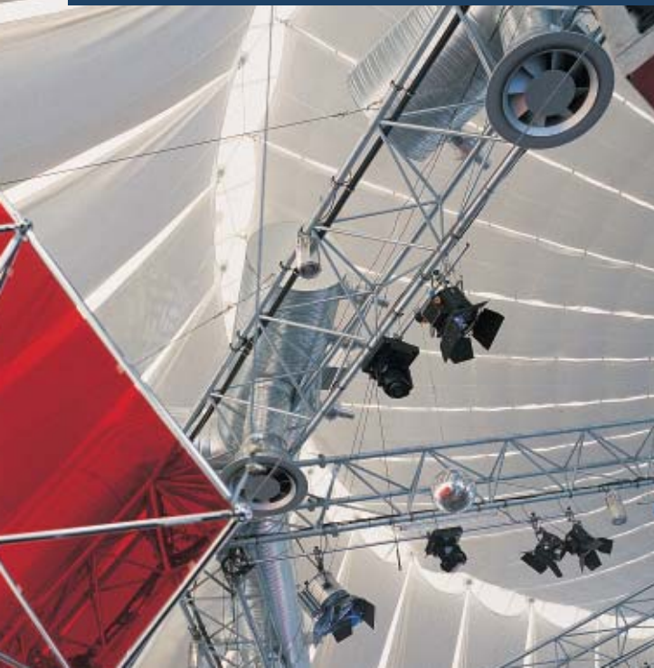
Variabler Drallauslaß mit Drallzylinder, Typ DD-VZ im Mediadrom, größte Traglufthalle Europas
