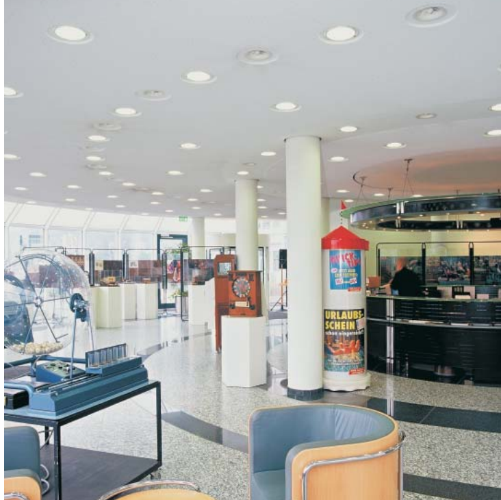
Drallauslaß, Typ DD-N im Eingangsbereich Lotto Toto, Rheinland Pfalz, Koblenz
