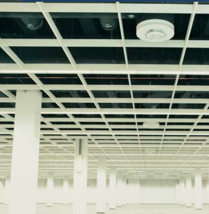
Variabler Drallauslaß mit Sekundärverteiler, Typ DD-SL in der Ausstellungshalle "Messe Köln"
