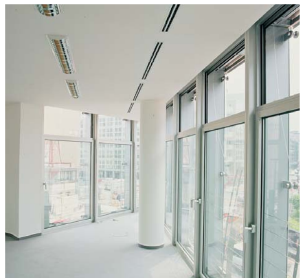
Verstellbarer Induktivauslaß Typ IN-V im Bürogebäude "Triangel", Berlin
