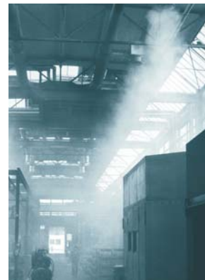
Luftstrahlausbildung DD-VK und DD-VZ unten: horizontale Strahlrichtung (Kühlfall) links: vertikale Strahlrichtung (Heizfall)
