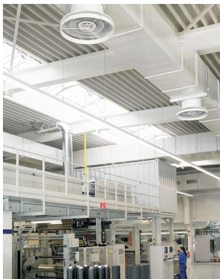
Verstellbarer radialer Verdrängungsauslaß mit zusätzlichem Leitring, Scheyer Verpackungstechnik, Klaus / A
