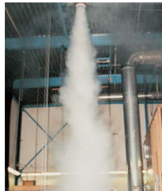
Luftstrahlausbildung DD-VG (im Heizfall)
