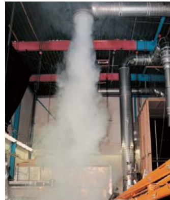
Luftstrahlausbildung DD-SG (im Heizfall)
