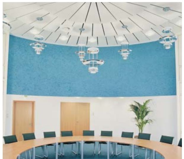
Variabler Drallauslaß mit Drallzylinder, Typ DD-VZ in einem Besprechungsraum Geno Rechenzentrum, Frankfurt
