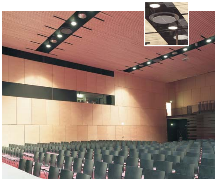
Drallauslaß, Typ DD-VK mit Gleichrichter im Saal der ARLBERG-well.com, St. Anton am Arlberg / A
