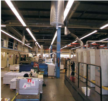
Circular displacement outlet, type VA-ZD, Tijl, Zwolle / NL
