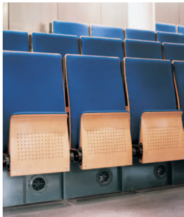
Bild 5: Stufendrallauslässe, Drallauslass DS-DD-DN 100, in einem Auditorium
